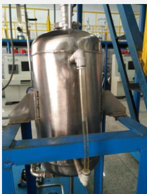
回流罐 (塔顶产品罐1/3)
